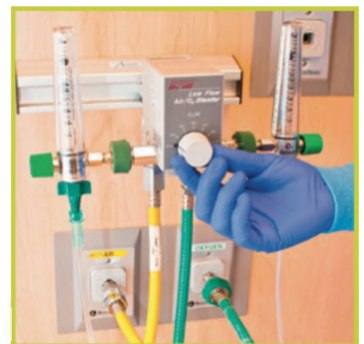
Figura 3.19. Ajuste la concentración de oxígeno con aire comprimido (entrada de la manguera amarilla), oxígeno comprimido (entrada de la manguera verde), un mezclador de oxígeno, un flujómetro y un tubo para el paciente (salida de tubo transparente). Esta imagen muestra 2 flujómetros conectados al mezclador de oxígeno. Su sistema puede tener solamente 1 flujómetro.
