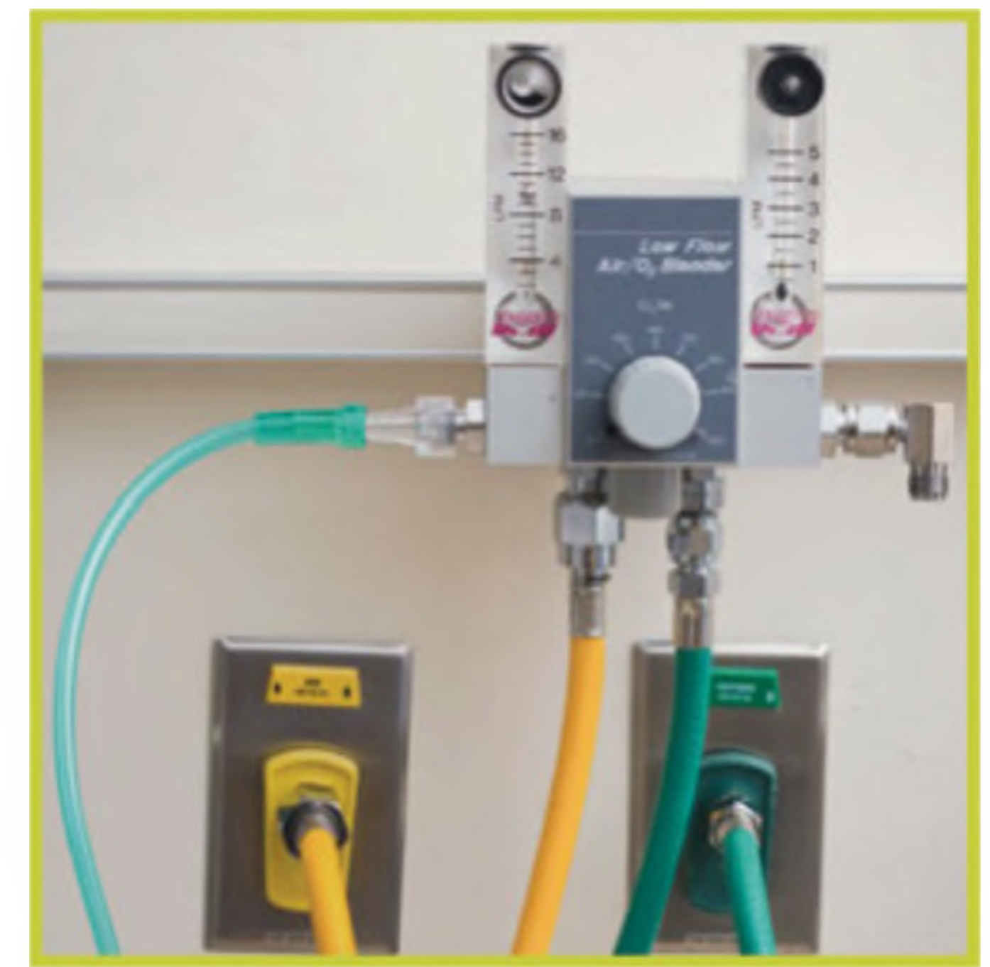
Figura 4.16. Flujómetro fijado a 10 l/min. Ajuste el mezclador a la concentración de oxígeno deseada.
