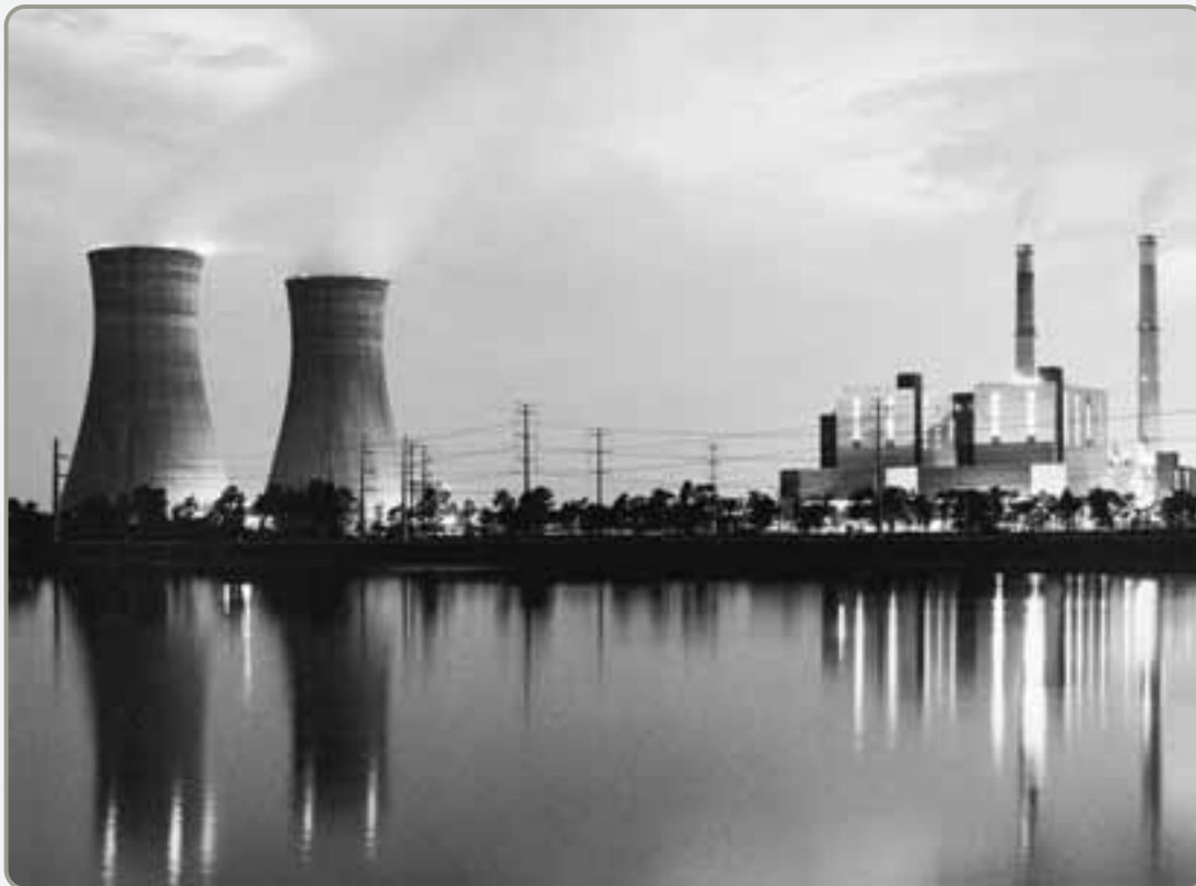
▲ Centro de Energía Stanton en Orlando
