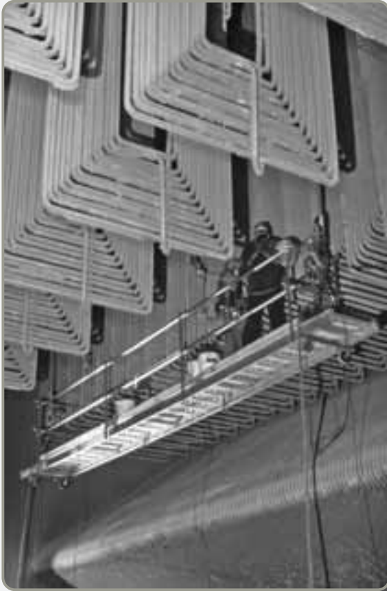
◀ Dos empleados están sobre un andamio cerca de la punta de la caldera del Centro de Energía Stanton, la cual tiene una altura equivalente a 23 pisos; los trabajadores revisan y reparan los súper calentadores.
